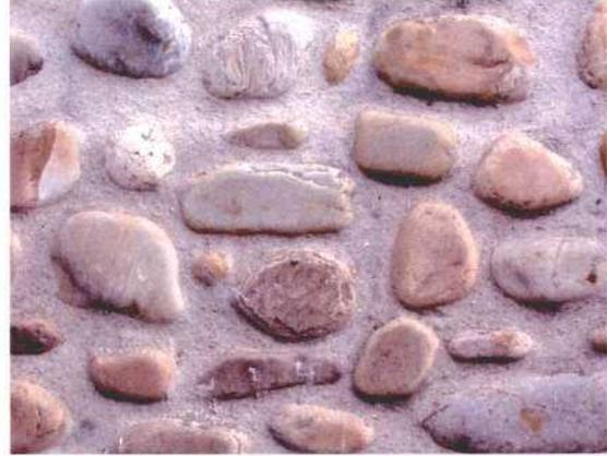
**Fotografía 52.-** Detalle de muro construido con cantos rodados de cuarcitas en el valle de Quiroga (Lugo).
